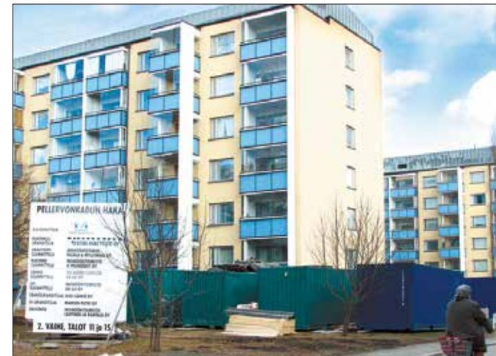
Pellervonkadun Hakan taloissa on menossa iso remontti, jossa esimerkiksi uusitaan sähkö- ja viemäriverkot.
