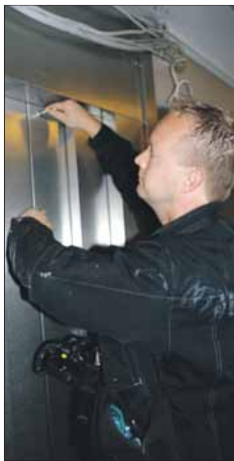
Tarkastusinsinööri Mikko Hietalahti varmistaa, että hissi pelaa niin kuin pitääkin.
