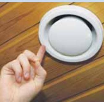
Venttiili irrotetaan kiertämällä sen ulkokehää.
