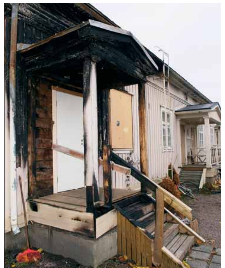
Remontti aloitetaan tulipalon vaurioittamasta talosta.
