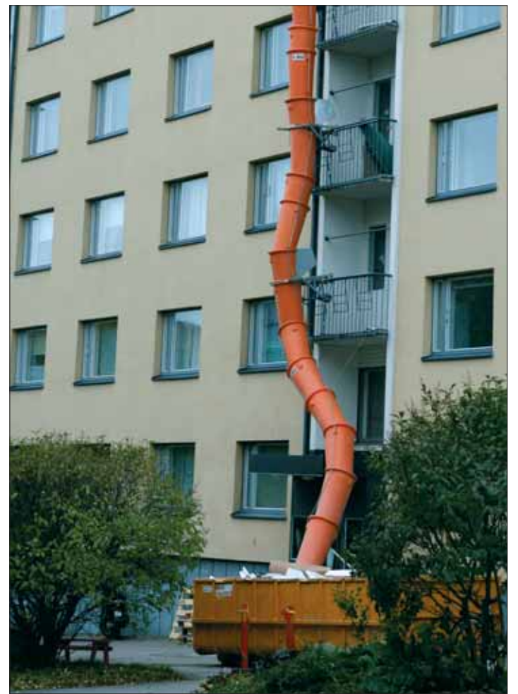
Pellervonkadun taloja remontoitiin yli kolme vuotta.
