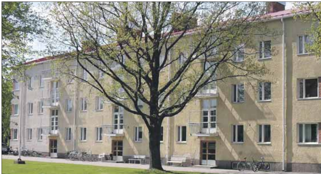
Koivukujan vanhat talot peruskorjataan läpikotaisin. Taloihin tulee yksi lisäkerros, hissi sekä näillä näkymin myös parvekkeet jokaiseen asuntoon.
