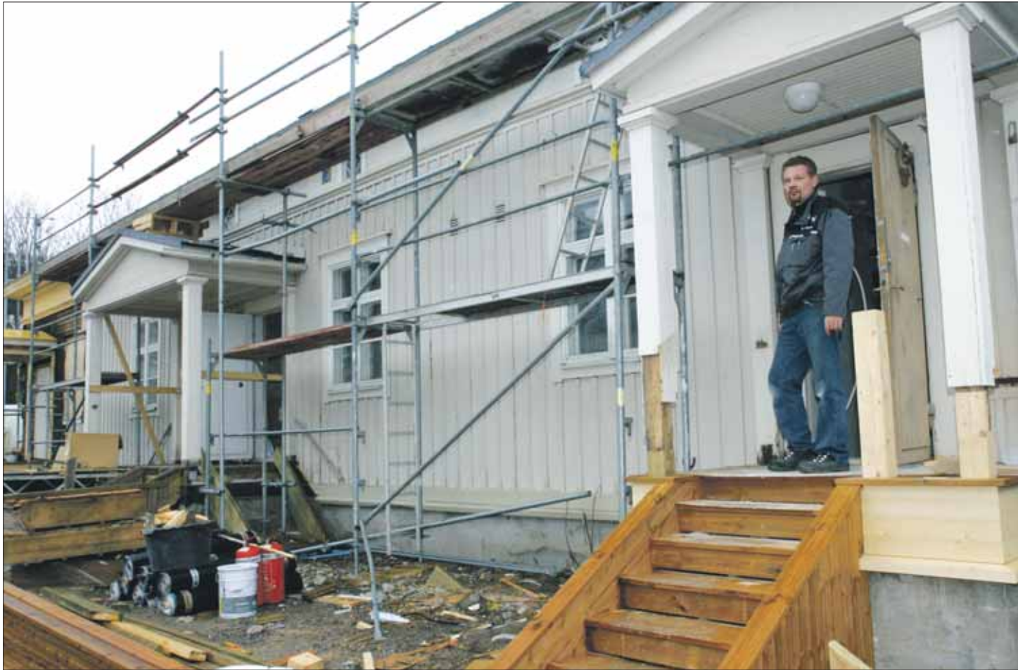
Työmaan vastaava Raimo Tuovinen on ensimmäisenä valmistuvan talon uudella kuistilla. Taloja ei ole vielä maalattu uusilla julkisivuväreillä.
